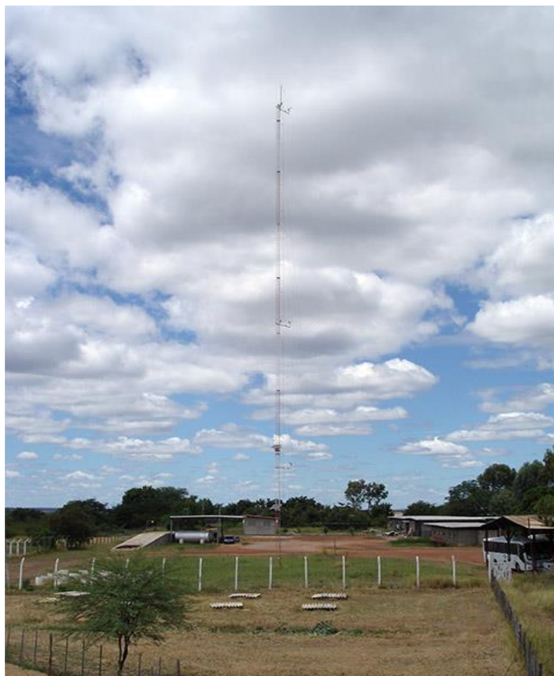
Figura 9 - Torre anemométrica na Estação de Petrolina.
