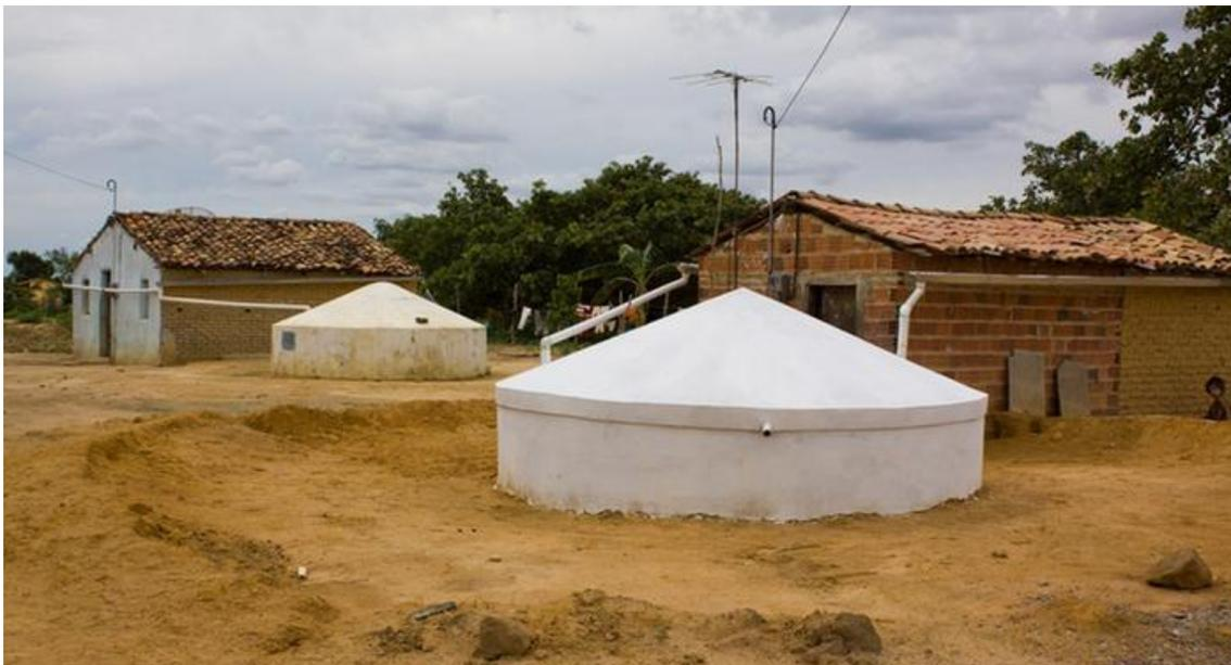
**Figura 3:** Cisternas de placas instaladas em residência na comunidade de Serra Grande, em Serra Talhada – PE.
